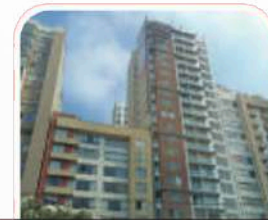
CONSTRUCTORA MARTE OBRA ESCOBEDO
